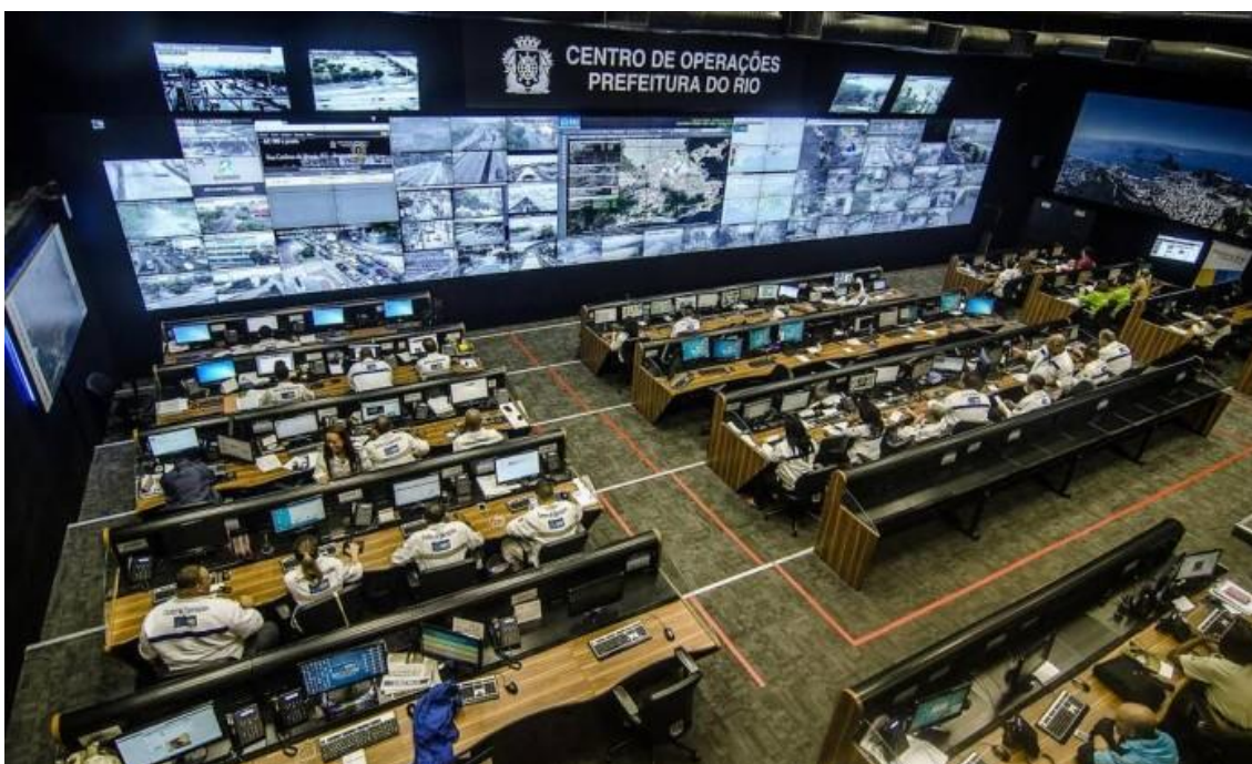
Figura 3. Sala de controle do Centro de Operações Rio.
